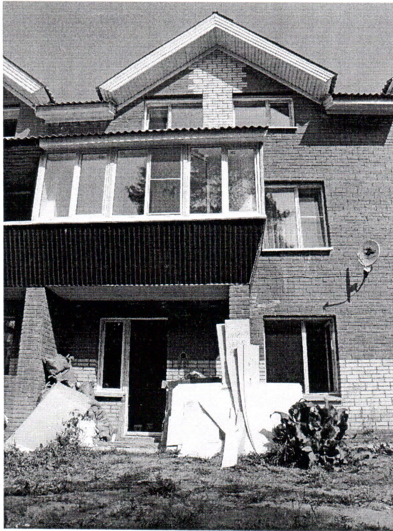
Фото1. Расположение оконного проема на фасаде.
